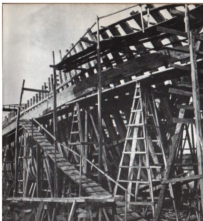
Construction du Banc d'Arguin Langoustier de 37,60 m
